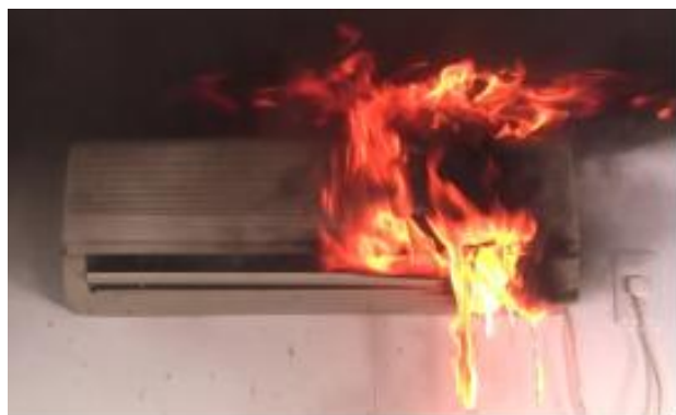
エアコン室内機の内部から発火する様子
