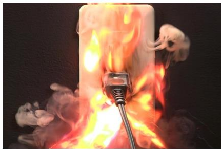
電源プラグ内部の破損による発火
