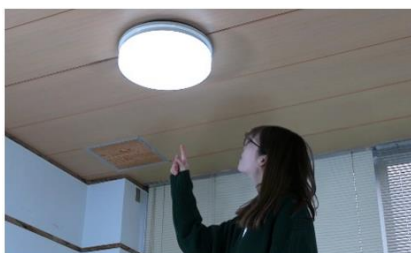
異常が無いか確認している様子
