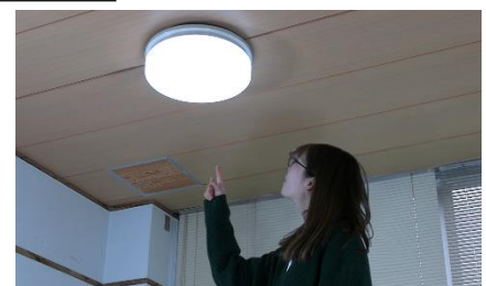
異常が無いか確認している様子
