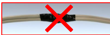
電源コードの継ぎ足し接続（ねじり接続）
