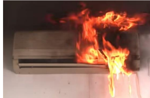
内部洗浄の不備による発火
