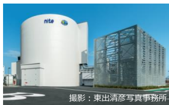
多目的大型実験棟 (NLAB Large Chamber)
