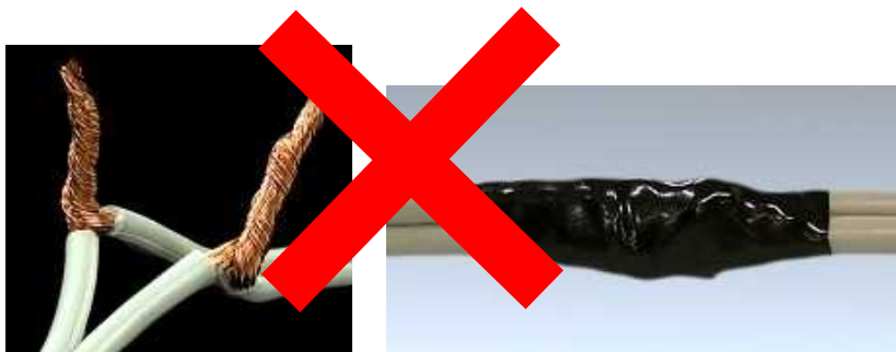
(写真)コードのねじり接続の様子
