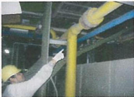
1F・2Fの分岐配管よりガス漏れの発生発見
