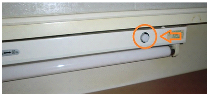
点灯管装着例（丸内が点灯管）
